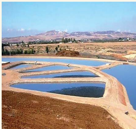
Station d'épuration de Ain Taoujdat
